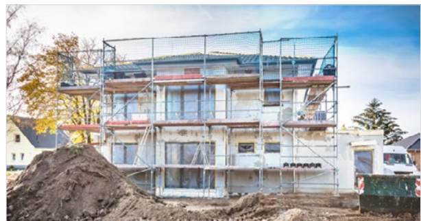
Neubauten sorgfältig trockenlüften
